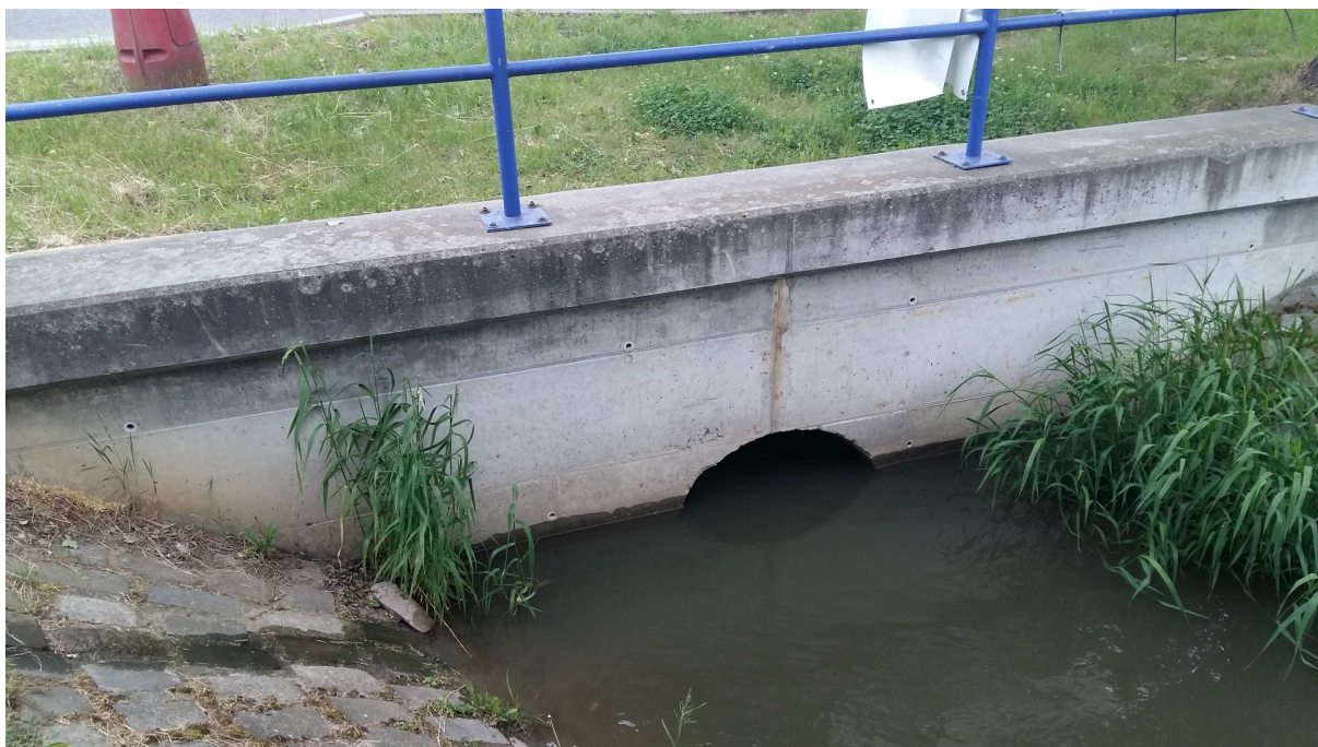
Obrázek 10 – Výtokový objekt zatrubnění – DN 1000 v ř. km 11,123
